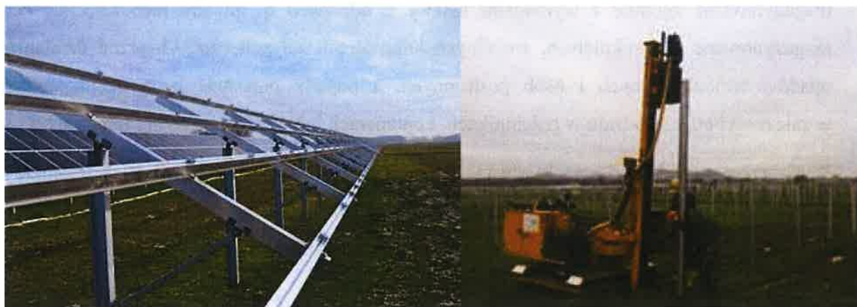
Rysunek 5 Sposób montażu konstrukcji, na których montowane są panele PV [Źródło: gramwzielone.pl]
